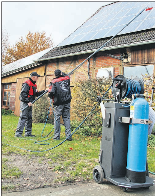
Mithilfe einer Teleskopstange kann die Solaranlage bis zu einer Höhe von 15 m vom Boden aus gereinigt werden. Das hierzu verwendete Wasser wird vorher mit der hier abgebildeten Anlage entmineralisiert. Fotos: Stückemann
