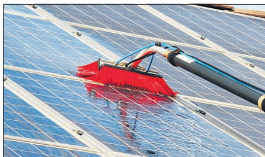
Durch die Reinigungsbürste fließt an mehreren Stellen mineralfreies Wasser.
